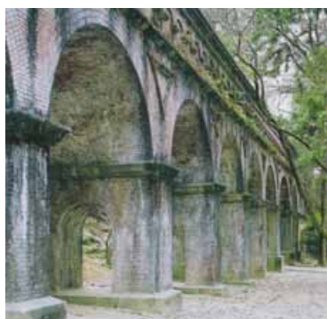
水路閣(南禅寺)
