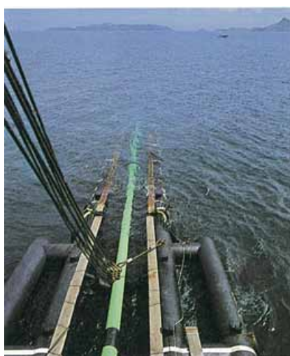
スティンガーによる敷設状況
