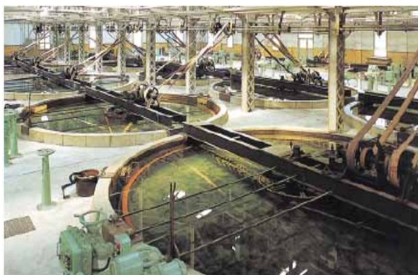
旧急速ろ過場（現存していない）
