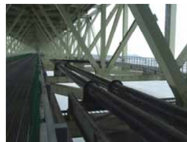
大橋に添架された送水管
