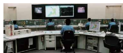
送水管理センター
