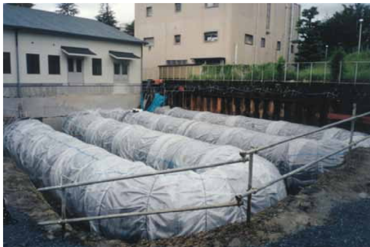
布設工事中の香里受水場 耐震性貯水槽
