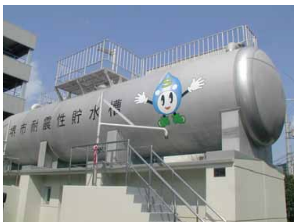
堺市の地上式耐震性貯水槽
