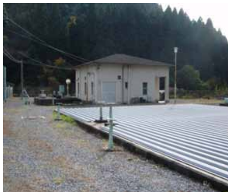
大原簡易水道 第1浄水場: 緩速ろ過方式
